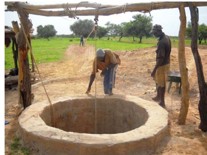
Les trois ouvriers originaires du Mali ont creusé le nouveau puits du village d'une profondeur d'environ 80 mètres en un peu plus de 16 mois.
